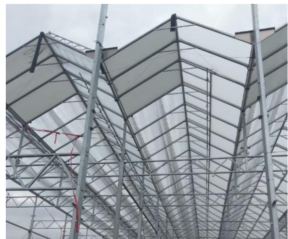
De eerste kas in aanbouw
